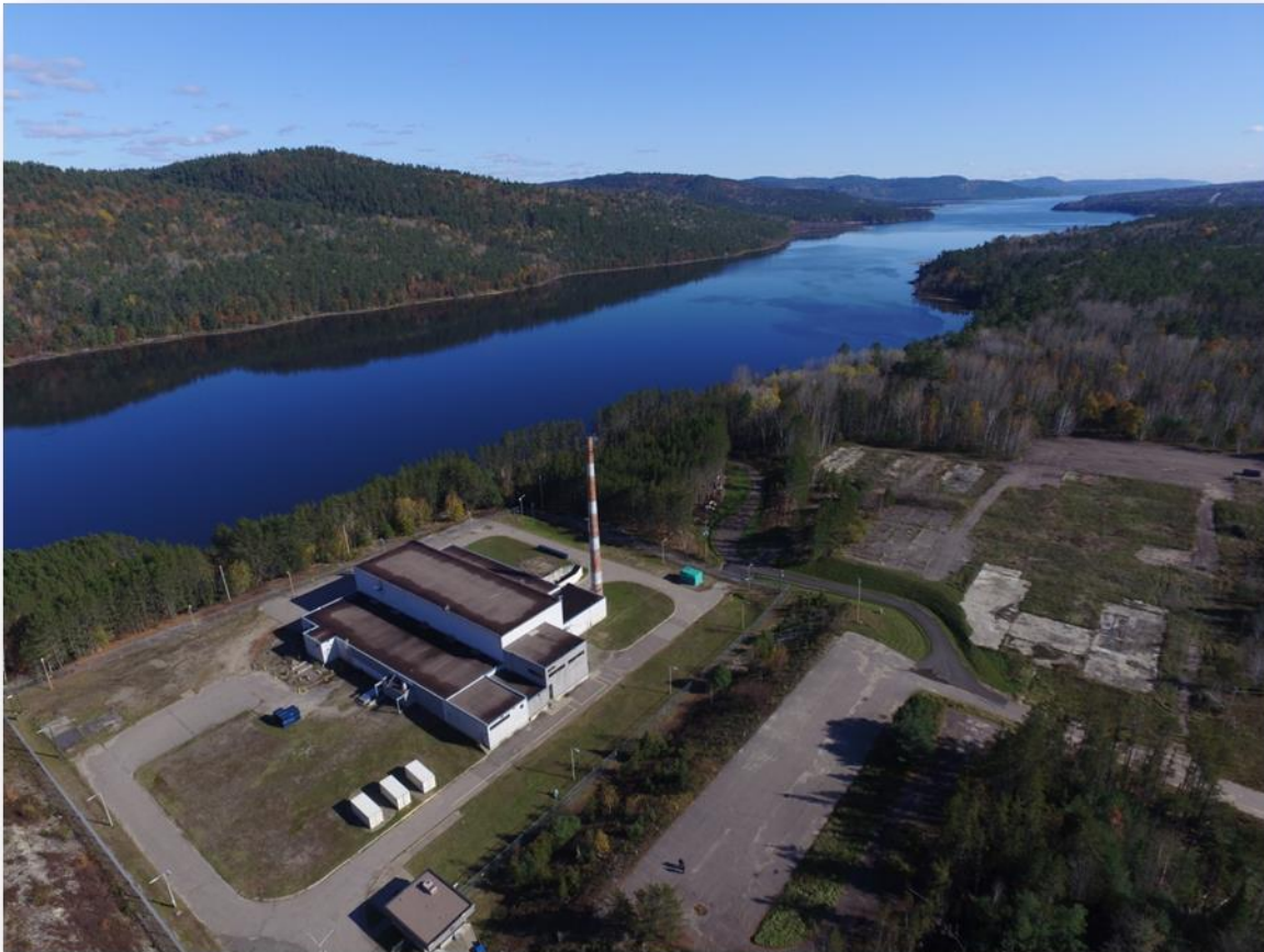
Figure 2-1 - Installation de gestion des déchets du réacteur nucléaire de démonstration
